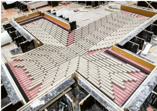
Einlegen der als Sonderziegel hergestellten Ziegelriemchen in die Schalungsmatrizen.
