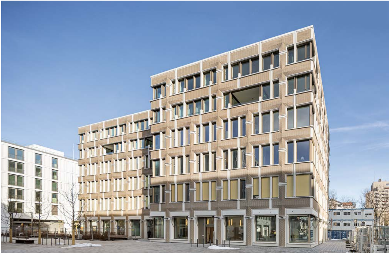
Westfassade des Baus. Die Fläche mit Klinkern im Römerformat 240 \times 115 \times 40 mm beträgt rund 1600 \text{ m}^2 .
