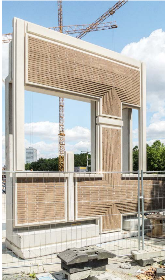
Musterfassade im Massstab 1:1, um Materialität, Farbigkeit und Proportionen zu überprüfen.
