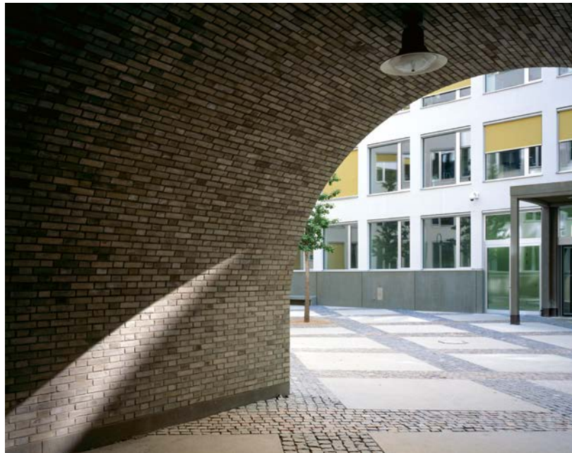
Hauptsitz der Bremer Landesbank: Beim Durchgang zum Innenhof trifft der opulent eingesetzte Backstein der Strassenfassade auf die schlichte weisse Putzfassade des Hofes.
