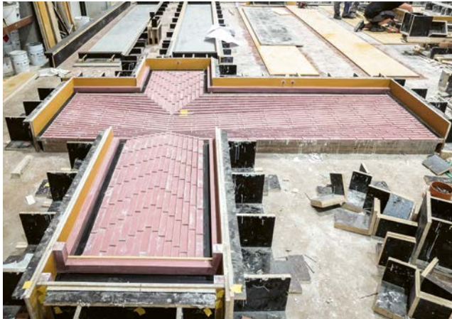
Schalungsmatrize mit Randeinlagen aus Schaltafelstreifen. In den Grundschalungskörper wurde zunächst eine Reliefschalung aus Schichtholz eingelegt, um die lagenweise Auskragung der Ziegelreihen zu modellieren. Darauf liegen Latexstreifen in Ziegelbreite mit entsprechend angeformter Fuge.
