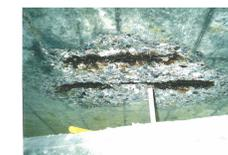
Betonabplatzung an Brückenplatte
