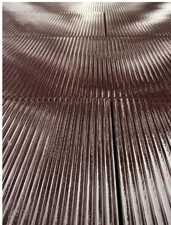
Die PV-Fassade am Haus «Solaris» in Zürich Wollishofen mit dem typischen **vertikal verlaufenden Strukturen des Gussglases, dessen rötlicher Farbdruck die PV-Zellen versteckt**. Das asymmetrische Profil des Glases ergibt Reflexionen, die an Lichtspiele auf einer Wasseroberfläche erinnern.
