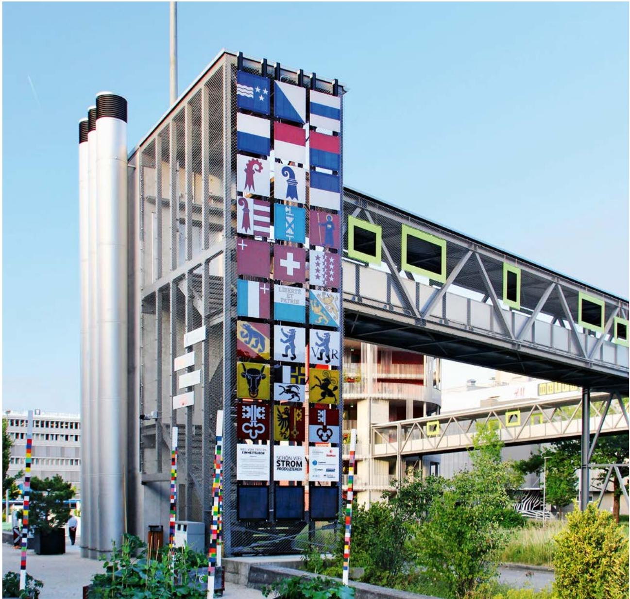
**Die PV-Fassade «Swissness»** besteht aus farbigen Modulen mit Motiven aller Schweizer Kantonsfahnen und der Bundesfahne. Sie demonstriert die Gestaltungsfreiheit von PV-Modulen mit digitalem Farbdruck. In der unteren Reihe sind baugleiche Module – allerdings ohne Farbdruck – montiert, die den visuellen und elektrischen Vergleich ermöglichen. Die Jahresproduktion dieser Module beträgt 840 kWh bei einer installierten Leistung von 1.59 kWp.
