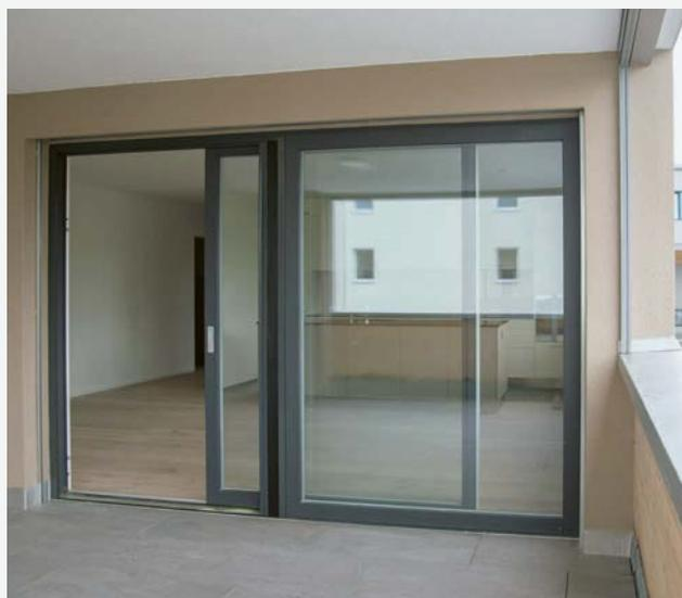
*Mit dem Profilsystem VEKA SOFTLINE 82 MD wurden Fenster in Normalgrösse und auch in Schaufenstergrösse hergestellt. Die Hebeschiebetüren sind stufenlos, die Fenster in der Getränkehalle mit Sonnenschutzglas ausgestattet.*
