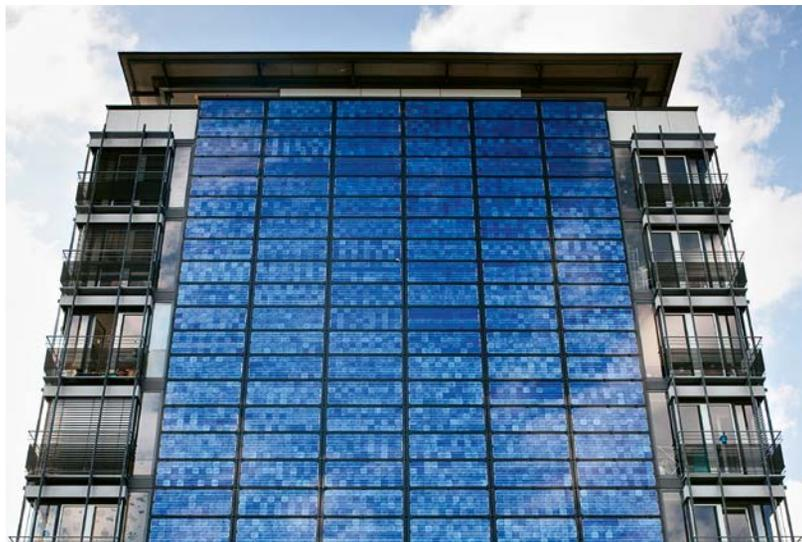
**Photovoltaik am Gebäude** ist längst nicht mehr nur eintönig blau wie in diesem Beispiel. Mittlerweile gibt es beliebig bunt bedruckte BIPV-Elemente.
