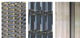
1. und 2. Detailaufnahmen des Chromstahlgewebes, dichte und weite Maschenbreite. 3. Ein mit Profil-Glas verklebter Liftschacht
