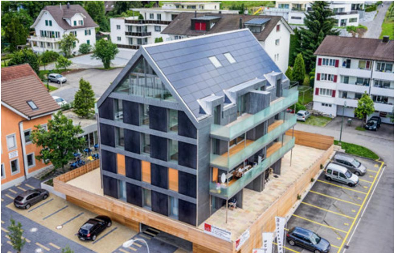
Die West- und Südseite des Mehrfamilienhauses Chrüzmatte in Aesch LU von Mark Rösli, 2016. Es deckt **mit dach- und auf der Westseite fassadenintegrierten PV-Anlagen rund 50% des Gesamtenergiebedarfs**. Drei Batteriespeicher mit einer Kapazität von insgesamt 41 kWh speichern den Energieüberschuss für den Verbrauch in der Nacht. Die städtebauliche Einordnung und der architektonische Ausdruck – ebenfalls wichtige Aspekte einer baukulturell nachhaltigen Bauweise – werfen allerdings Fragen auf.
