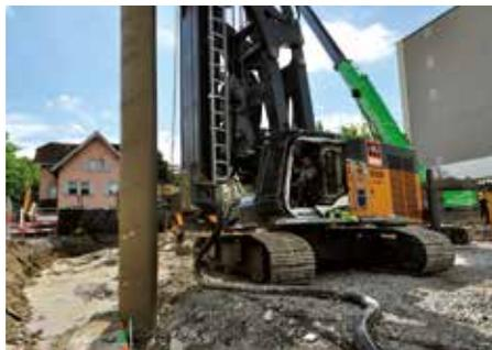
JMS RISI AG a dû réaliser une excavation dans une enceinte étanche à Zoug, car l'excavation était située dans la nappe phréatique pour deux niveaux souterrains. A cause de l'espace disponible, des émissions sonores et des vibrations, il n'a pas été possible d'opter pour des parois moulées ni des palplanches. JMS RISI AG a donc misé sur une paroi de pieux sécants (770 mm de diamètre), qui a été réalisée avec l'engin de forage Liebherr LRB 355 selon la méthode du forage à double tête.
