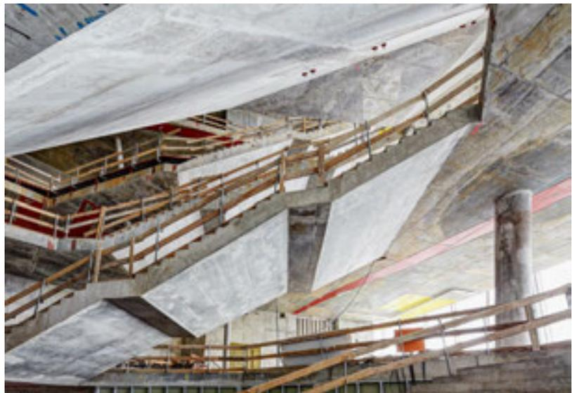
Die hochkomplexe **Tragkonstruktion aus Stahlbeton** bildet eine Landschaft aus Decken, Stützen und Treppen. Farbige Stellen markieren die Lage von Vorspannkabeln – statisch neuralgische Zonen, die keinesfalls verletzt werden durften.
