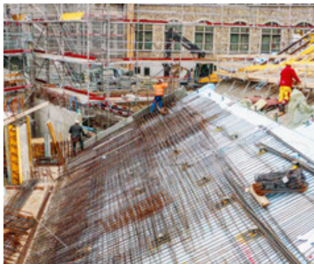
Baustellenfotos während den Ausführungsarbeiten an der Brücke. Die Neigungen der Brückenplatten betragen 45 und 27 Grad. Um sie betonieren zu können, sind Konterschaltungen erforderlich. Zuerst betonierte man die Untersicht der Brücke – die nichttragende Aussenhaut –, verlegte die Dämmung und die Bewehrung und betonierte anschliessend die tragende Platte.
