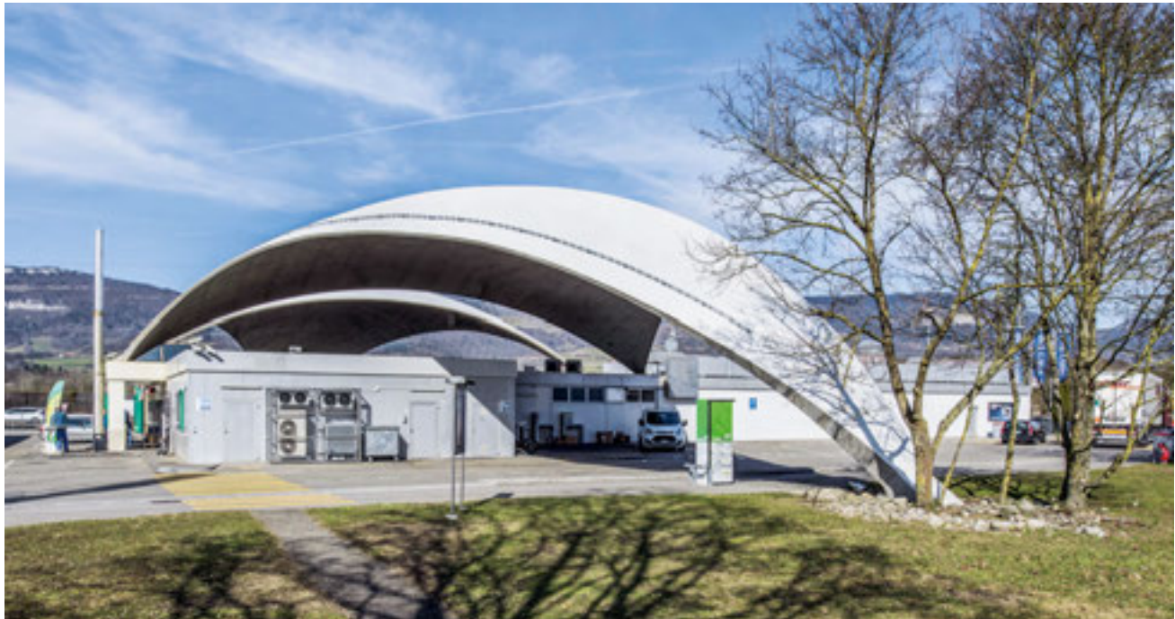
Die Schalen 2017 mit dem dominanten, aber originalen weissen Farbanstrich. Der neu angebrachte Schneefang wird der Anforderung der Betriebssicherheit gerecht; die Ästhetik der Schalen wird dadurch stark beeinträchtigt. Noch störender sind allerdings die Bauten darunter, die der ursprünglichen Funktion der Schalen als Dach widersprechen.
