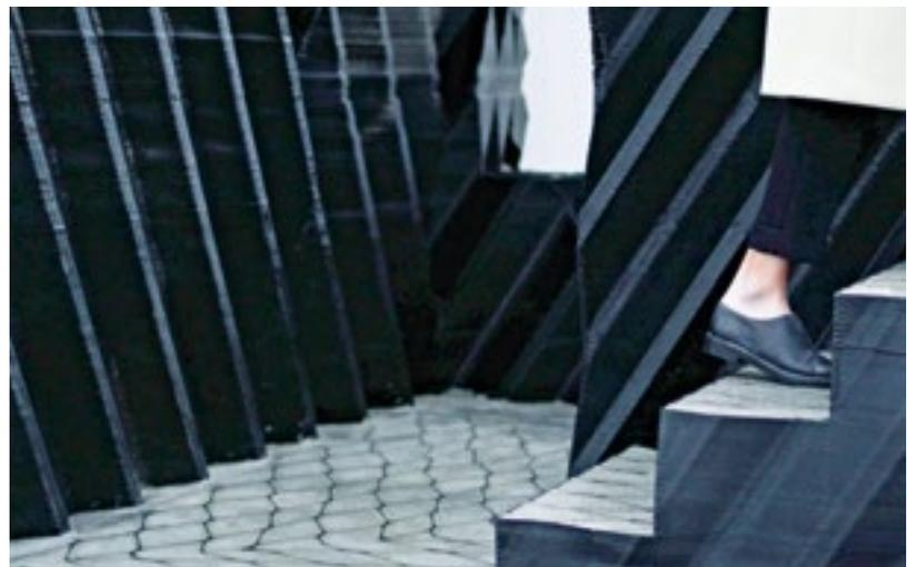
Durch den Einsatz von 3-D-Druck sind **Boden, Wand und Treppe im Amsterdamer Kanalhaus** nicht nur sprichwörtlich aus einem Guss.
