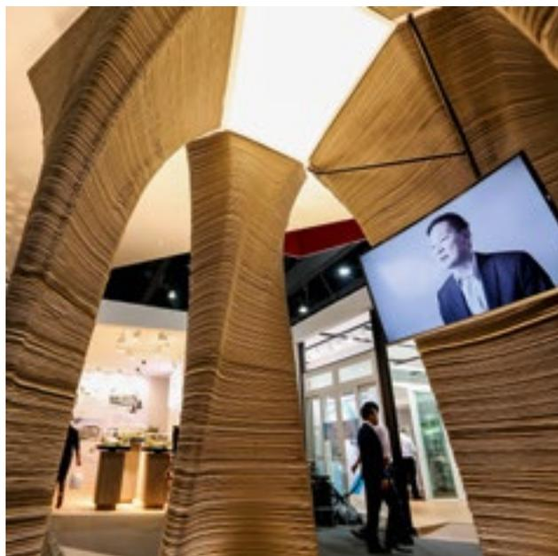
**Oben:** Für die Säulen eines Ausstellungspavillons auf einer thailändischen Baumesse verwendete Architekt Chaowakul einen 3-D-Drucker aus Italien. Seine Partnerfirma entwickelte speziell dafür eine dickflüssige, schnell trocknende Zementmischung.
