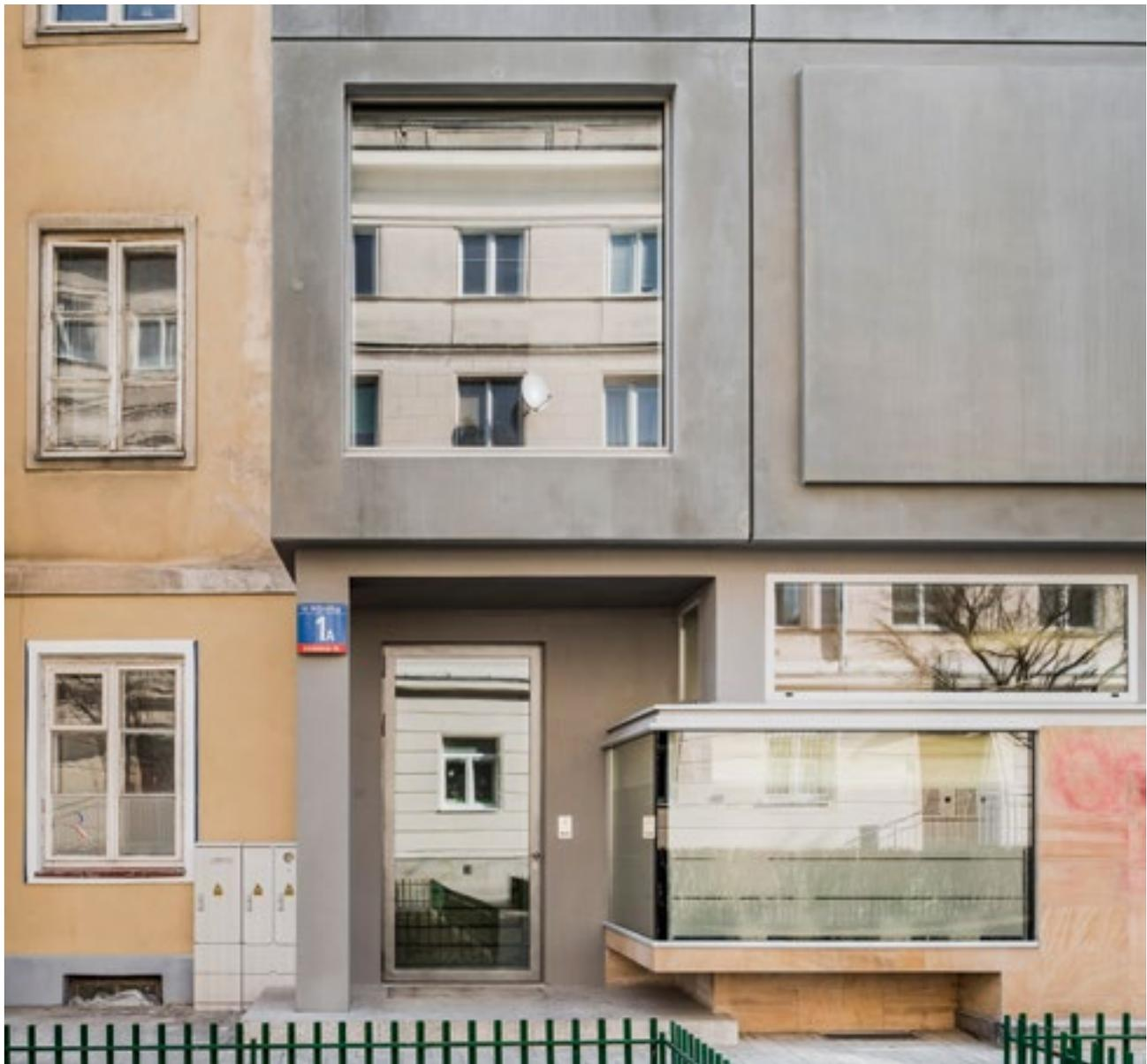
Nordseite: Das Erdgeschoss blieb unverändert, die Obergeschosse erhielten eine Fassade aus vorfabrizierten Betonelementen.
