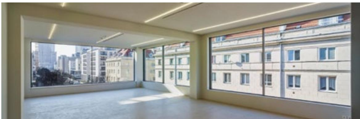
**Ausstellungsebene im 3.OG:** Die Betontragstruktur blieb erhalten und trägt die neue Fassade; die Heizung ist im neuen Anhydritboden integriert. Durch die grossen Fenster auf der Ost- und Südseite schweift der Blick in die ulica Górskiego mit ihrer neotraditionalistischen Architektur der 1940er- und 1950er-Jahre.
