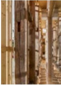
In der Fassade der Scheune in Dingenhart TG trifft das ursprüngliche Gebälk auf das neue Tragwerk im Innern. Was einst das Dach getragen hat, ist nun die Unterkonstruktion für die Fassade; wo früher Heu gelagert wurde und Landmaschinen eingestellt waren, wohnen nun Städter mit Sehnsucht nach dem Geläut von Kuhglocken und der dampfenden Erde frisch gepflügter Äcker.
