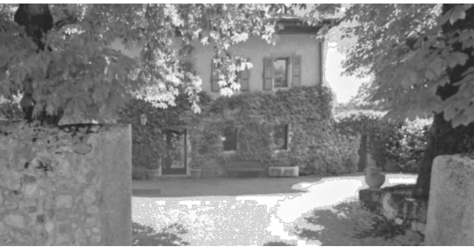
référence locale de végétation grimpante sur les façades
