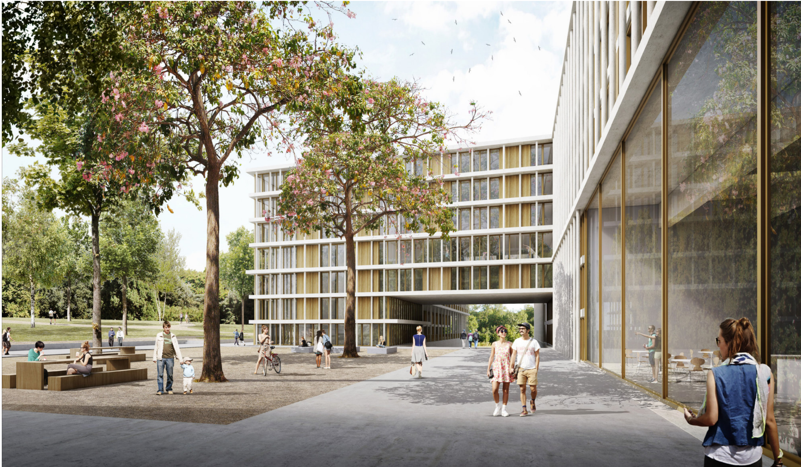
vue depuis la cour des logements
