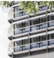
Technischer Fassaden Layer Oliveri Verwaltungs- und Ausbildungszentrum Frankfurt am Main, 1967-72 Architekt Egon Eiermann
