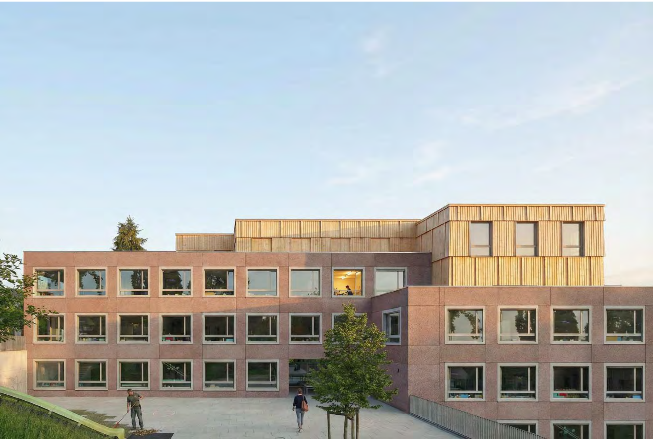
Blick auf Bestands- und Neubau
