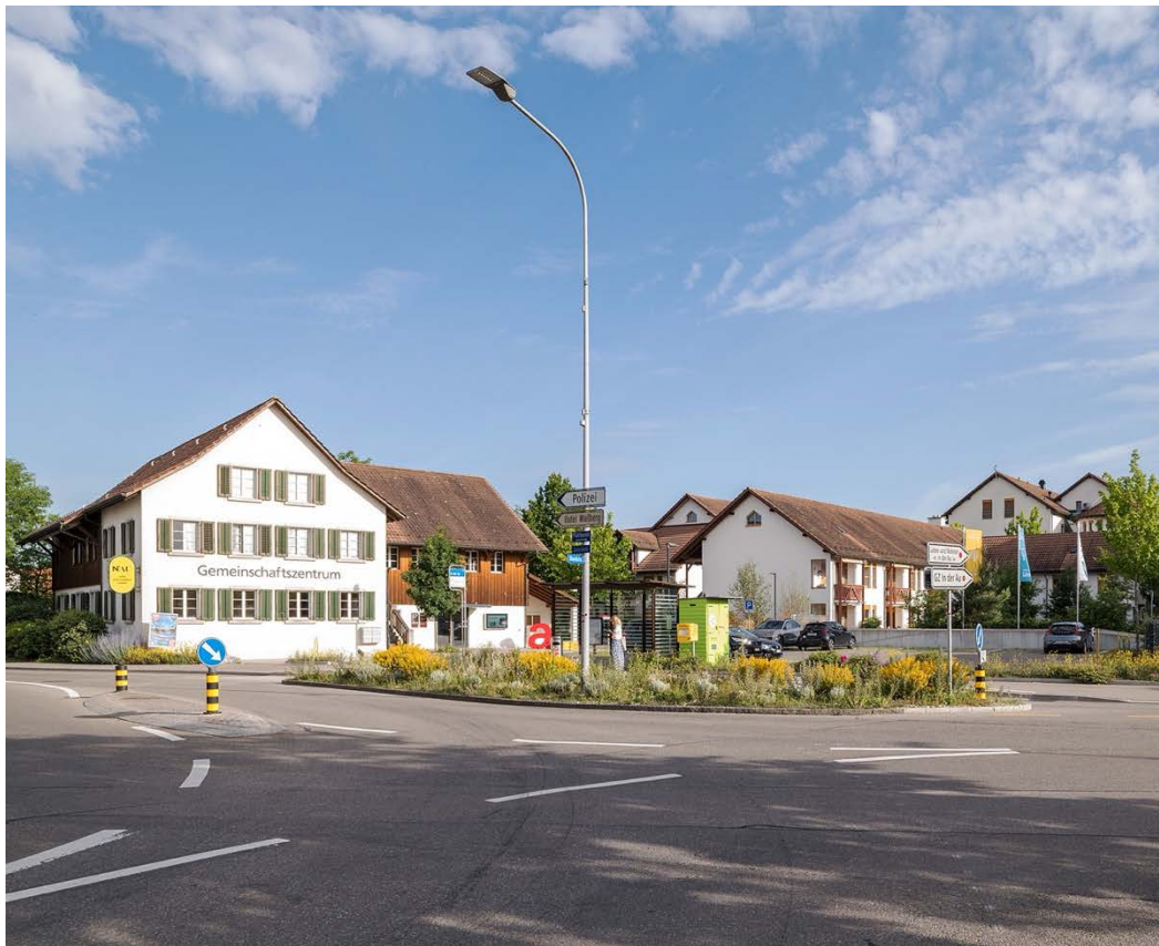
Abb. 7 Gemeinschafts- zentrum (links), Alters- und Pfl- gezentrum In der Au (rechts)
