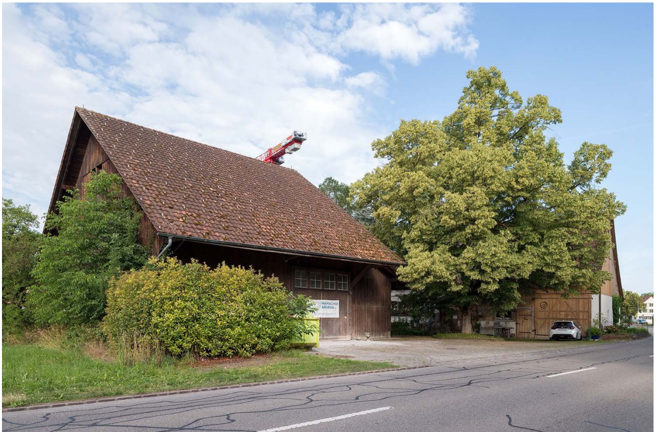
Abb. 5 Bestandsbauten Bauernhaus und Scheune an der Hardstrasse
