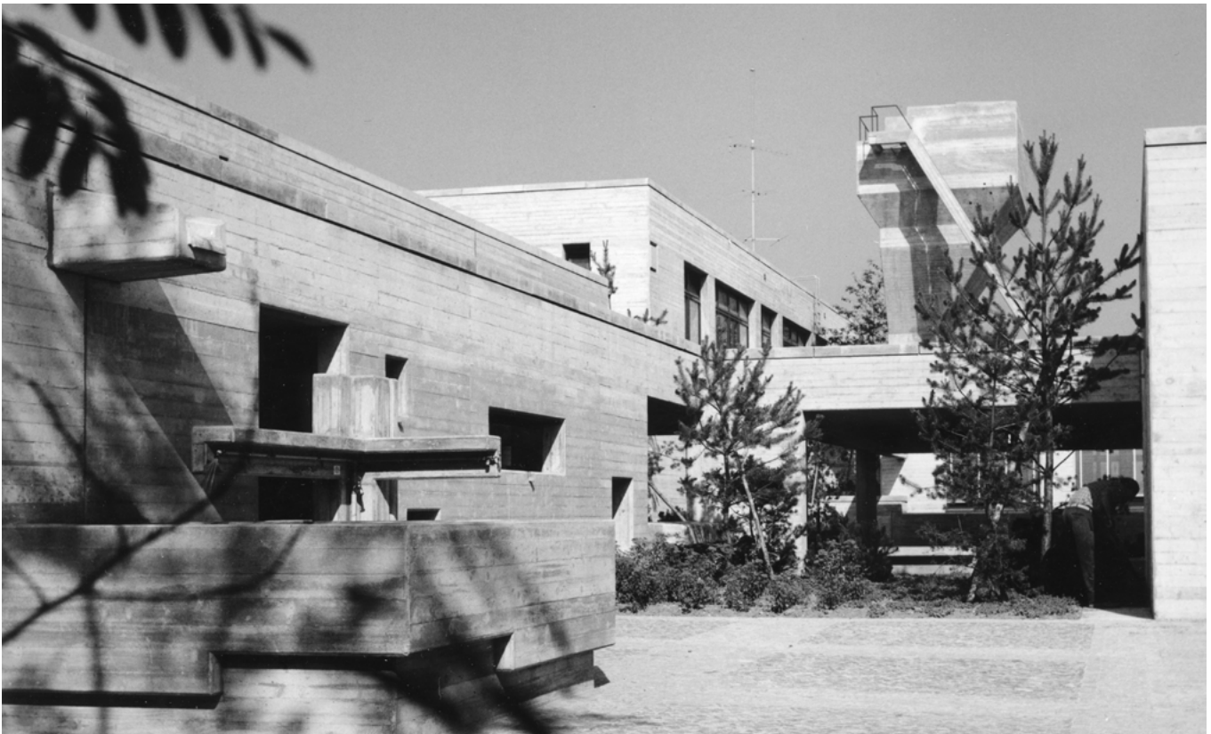
Werkjahrschulhaus (Foto: BAZ um 1965) Innenhof mit Holzspänesilo
