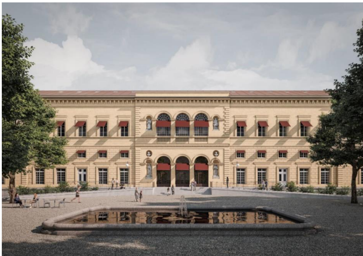
Façade Sud de Collège Latin. Crédits : Noue Studio, Chablais Fischer Architectes
