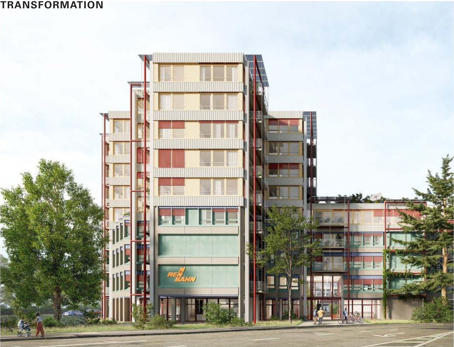
Blick von Birsfelderstrasse
