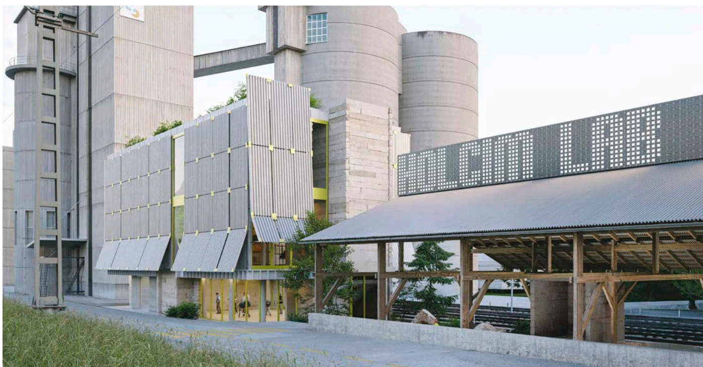
© Holcim Lab, Allen + Crippa und Julian Meier Architektur
