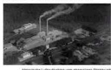
Historische Luftaufnahme von ehemaligem Stahlbauhof
