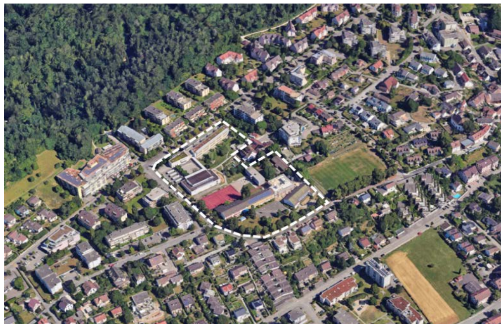
Schulanlage Kreuzgut Luftbild
