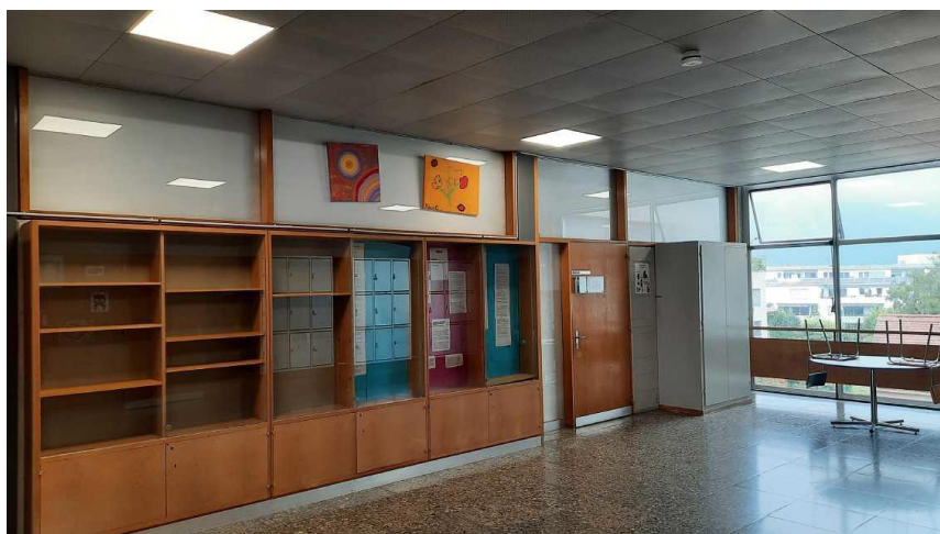
Paroi des salles de classe. Le mobilier en bois et les portes des salles de classe sont en bon état (ACL)
