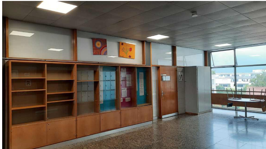
Front der Klassenräume. Die Holzmöbel und die Klassentüren sind in gutem Zustand (ACL)
