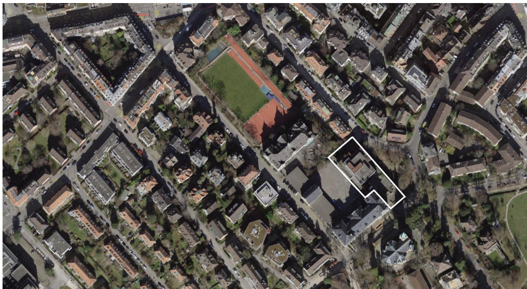
Abb. 1 Luftbild mit Perimeter (weiss), Schulgebäude Schrennengasse 7, 8003 Zürich, genordet Quelle: GIS Kanton Zürich, Orthofoto 2026
