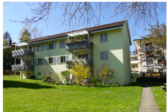
Wohnseite Zeilenbau (Etappe 16)
