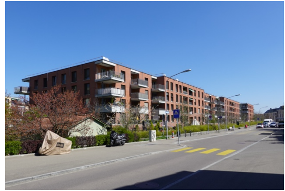
Dachslernstrasse, Nachbarbebauung «Im Stückler»
