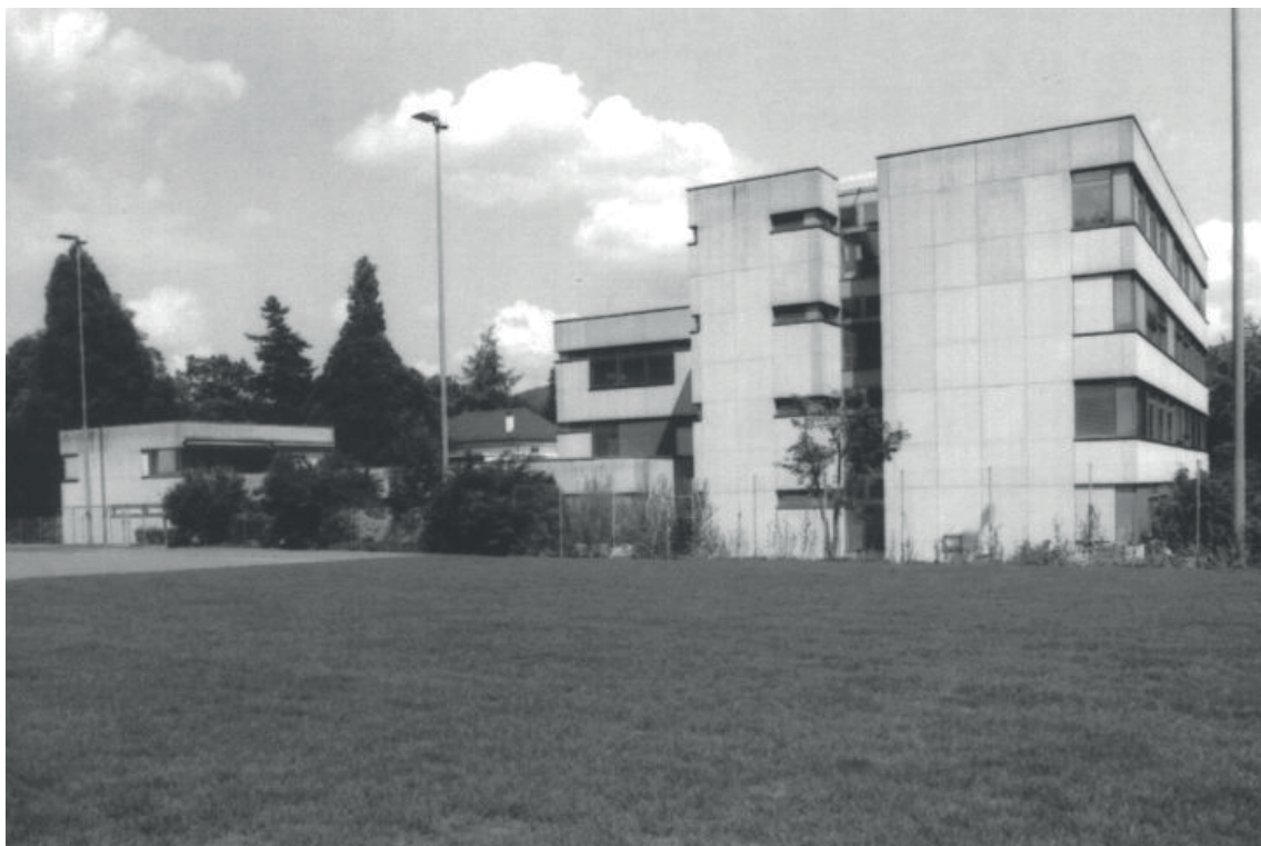
Abbildung 3: Hauptgebäude Schulhaus Mühleacker (Trakt D+E) nach Fertigstellung (Quelle BIB)
