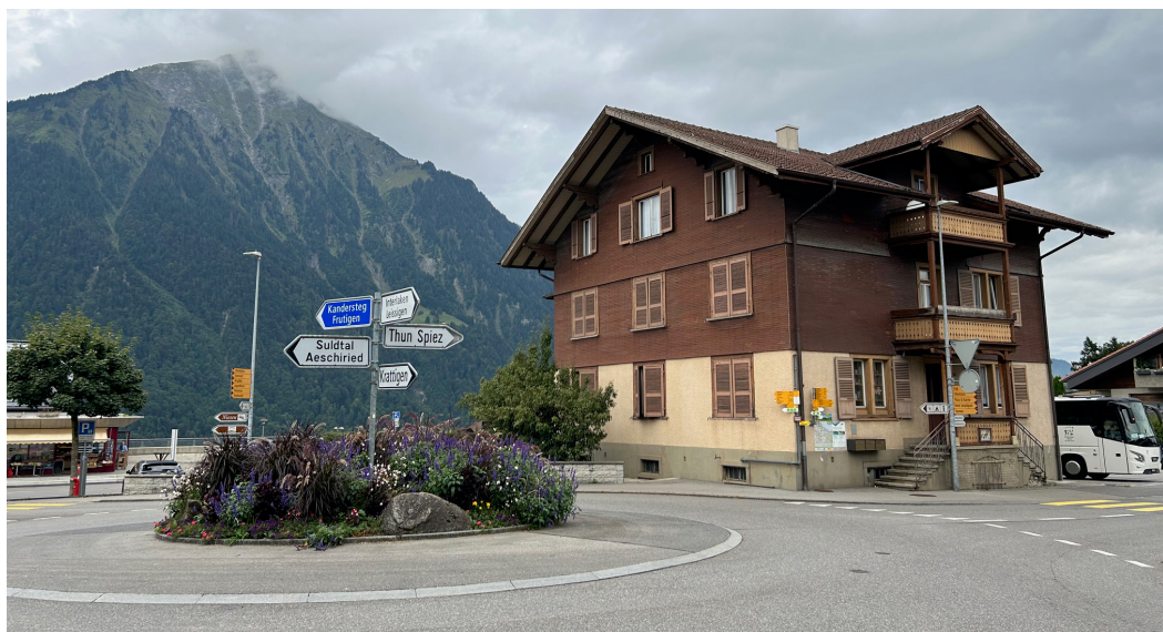
Abb. 2 Foto Areal Blüemlimatt mit Wohnhaus Dorfstrasse 1 am Kreisel im Dorfzentrum, Dorfplatz hinter der Liegenschaft, im Hintergrund der Niesen; 2024
