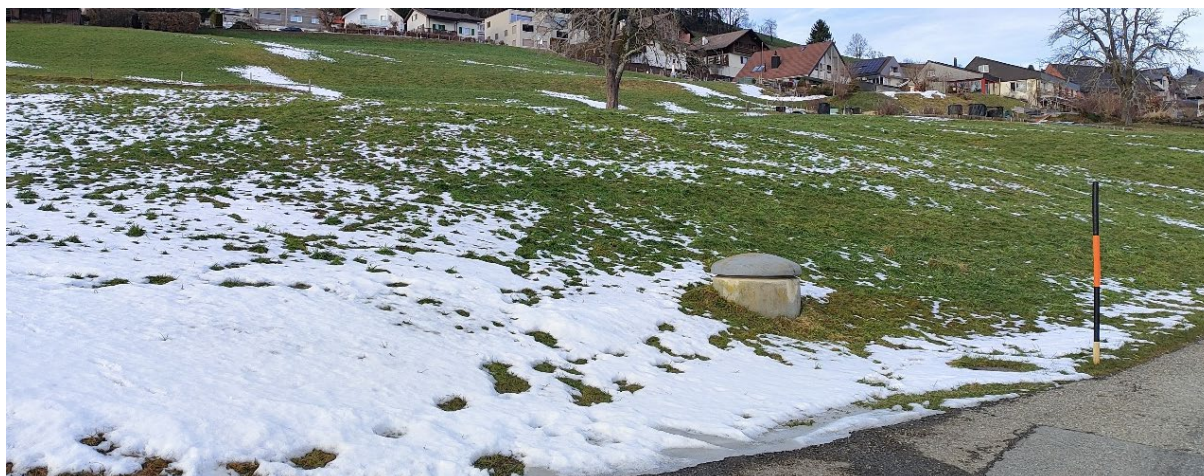
Abb. 10: Überdruckschacht vor Einfahrt Parzelle Nr. 970 Quelle: Eigene Darstellung | Januar 2026
