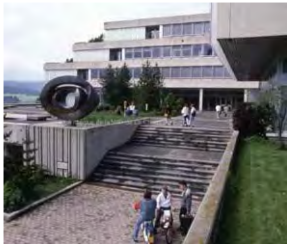
le bâtiment avant la rénovation de 1992
