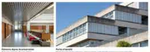
Intérieur après rénovation Partie d'intérieur montrant une rénovation soignée avec des matériaux modernes et une luminosité accrue.
