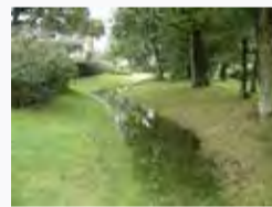
5 Noue remplie d'eau
