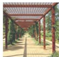
6. Passerelle avec végétation grimpante
