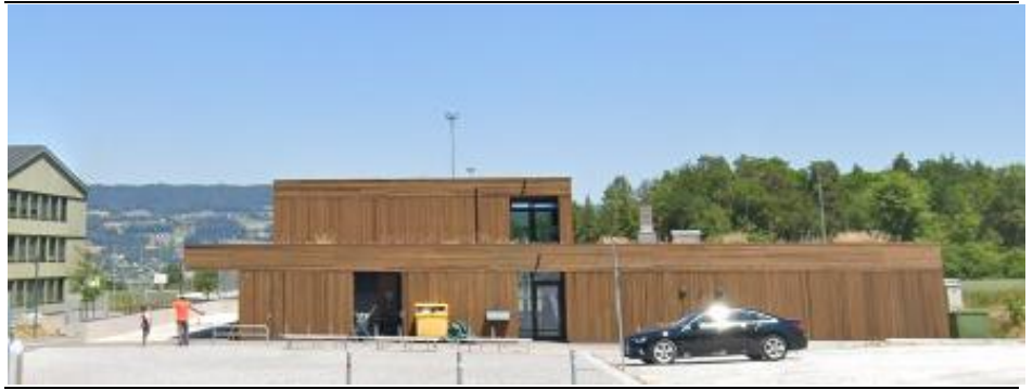
Abbildung 6: Garderobengebäude (Quelle: Google Maps)
