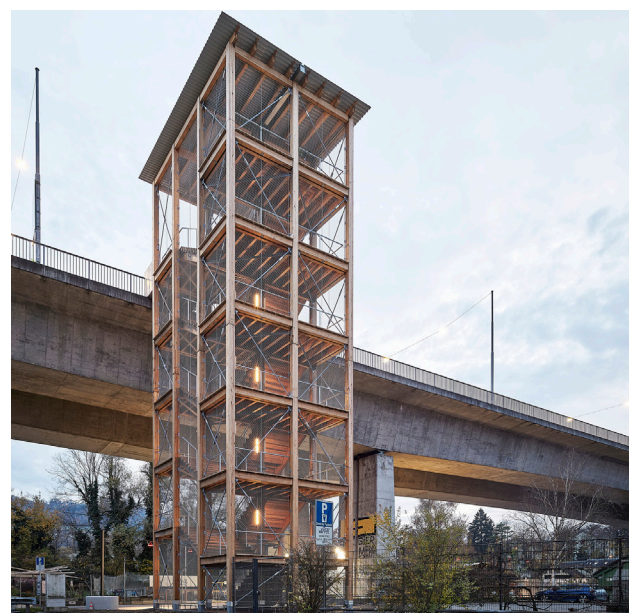
Foto Treppenturm Gaswerkareal
