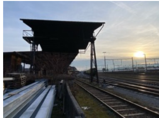
Blick auf das Gleisfeld Richtung Osten
