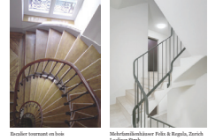
Escalier tournant en bois Mikrodenkmalhaus Pöhl & Regula, Zurich
