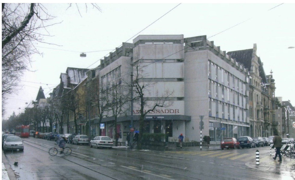
Ansicht Eckgebäude Thunstrasse / Helvetiastrasse (Thunstrasse 2) von 1969
