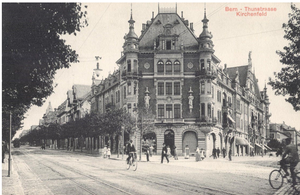
Ansicht Eckgebäude Thunstrasse / Helvetiastrasse (Thunstrasse 2) von 1896
