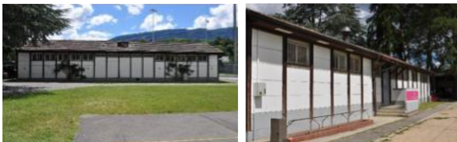
Fig. 12 : Vues sur le pavillon provisoire
