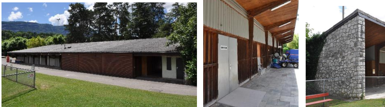
Fig. 11 : Le pavillon des gardiens construit entre 1945 et 1946.
