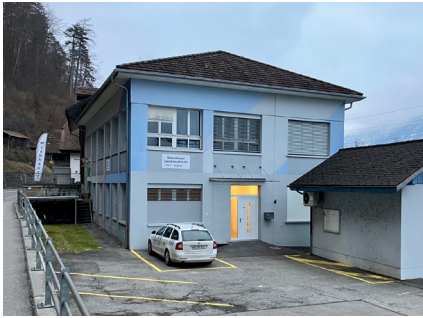
Abb. 5 Foto Gewerbehäuser bestehend Parzelle Nr. 2699, rechts im Vordergrund kleines Trafogebäude (inzwischen abgebrochen) Parzelle Nr. 3392, Zustand 2023 vor Realisierung Velounterstand / Busterminal
