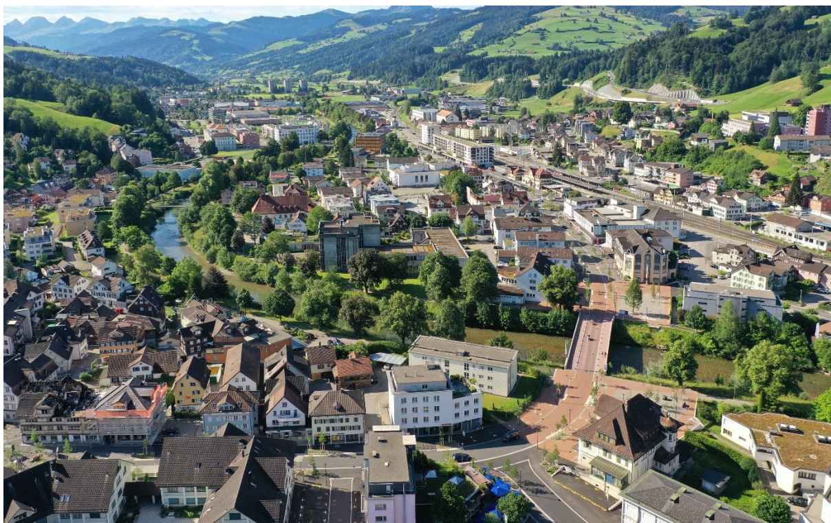
Abb. 9: Fotoaufnahme der Strassenraumgestaltung mit Blick Richtung Bahnhof Wattwil
