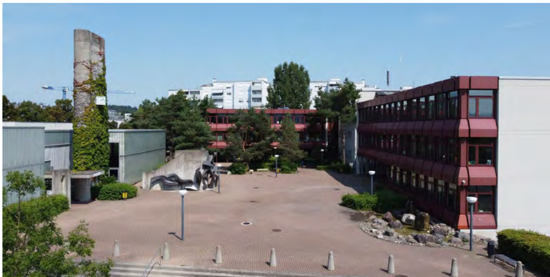
Schulanlage mit oberem Pausenplatz
