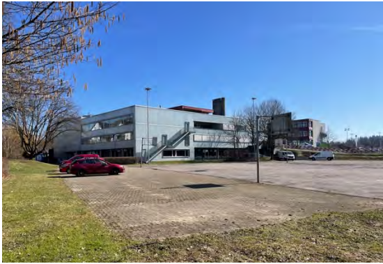
Baufeld – Blick zum Spezialtrakt
