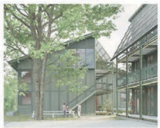
Im Garten ruhend Die Fassade bildet die Achse mit der Begrünung und hält Bewohnerinnen und Bewohner vom Versetzen.
