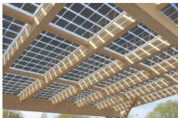
4. PANNEAUX PHOTOVOLTAIQUES SUR PERGOLAS
