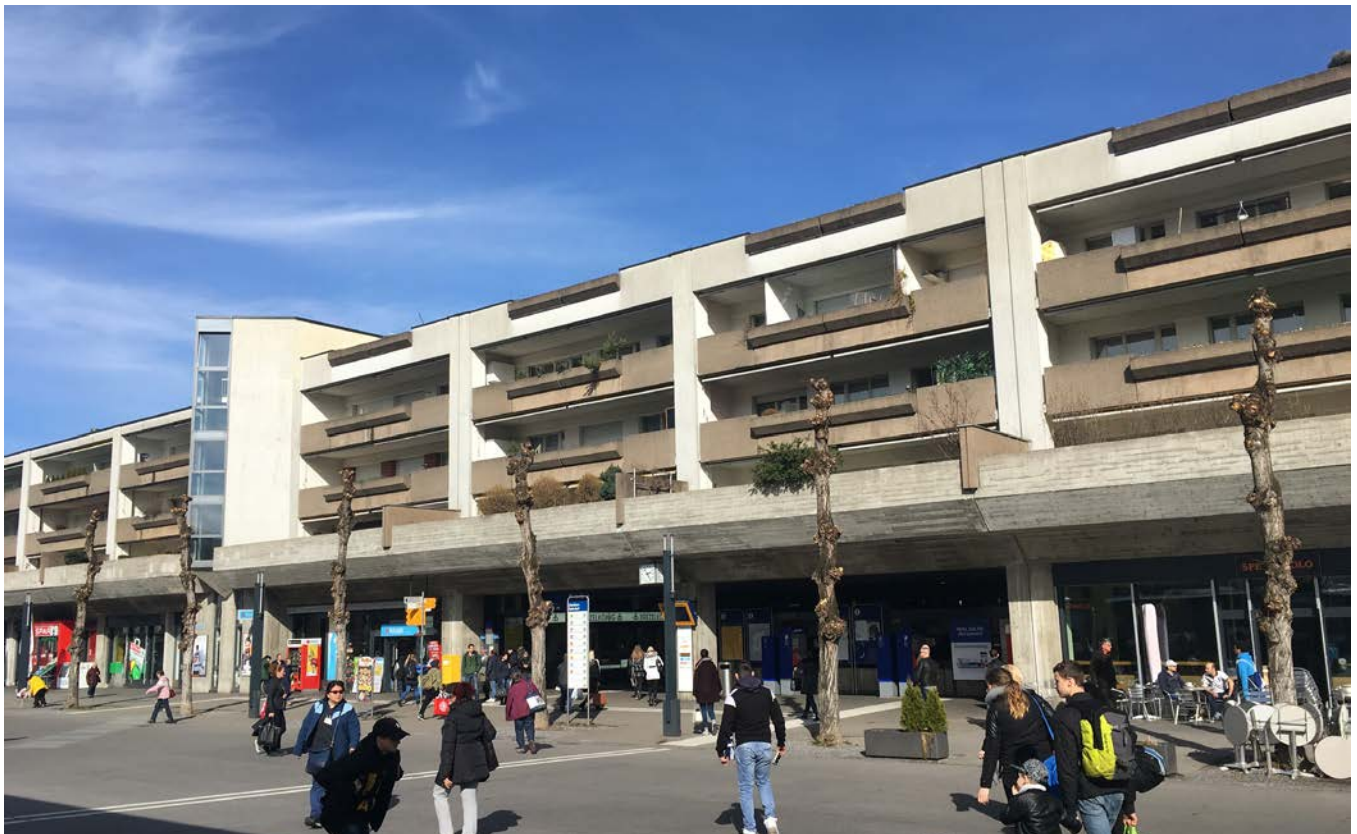
Abb. 4: Aufnahmegebäude Bahnhof Dietikon (Eckhaus | 02.03.2017)
