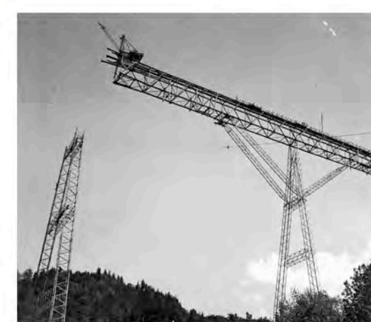
Haggenbrücke (Gangelibrücke), Stein AR - St.Gallen
