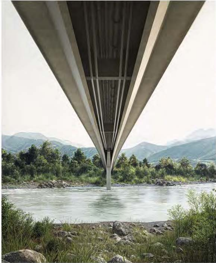
Vue sous l'ouvrage
