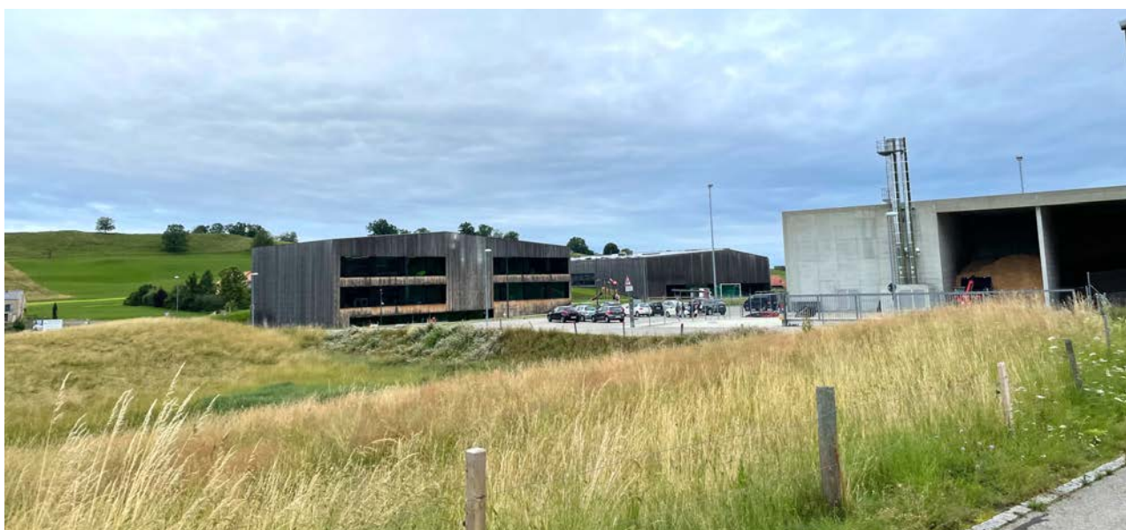
Vue des bâtiments situés au Nord de la parcelle (de gauche à droite : école primaire, salle de gym triple polyvalente, centrale de chauffe)
