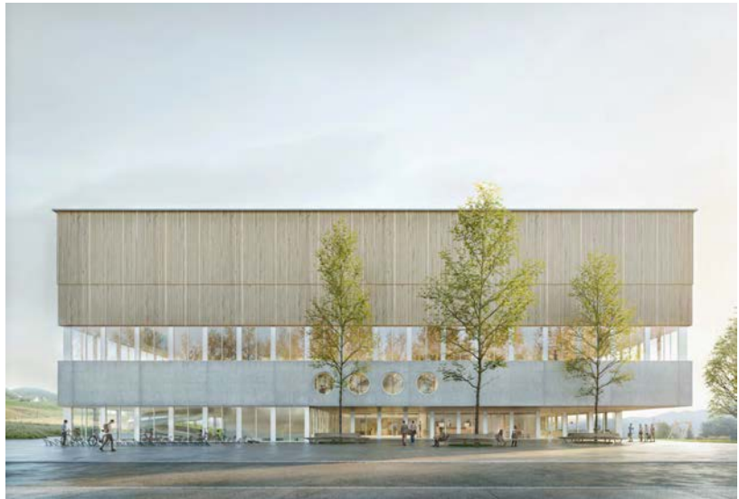
Entrée au nouveau centre sportif
