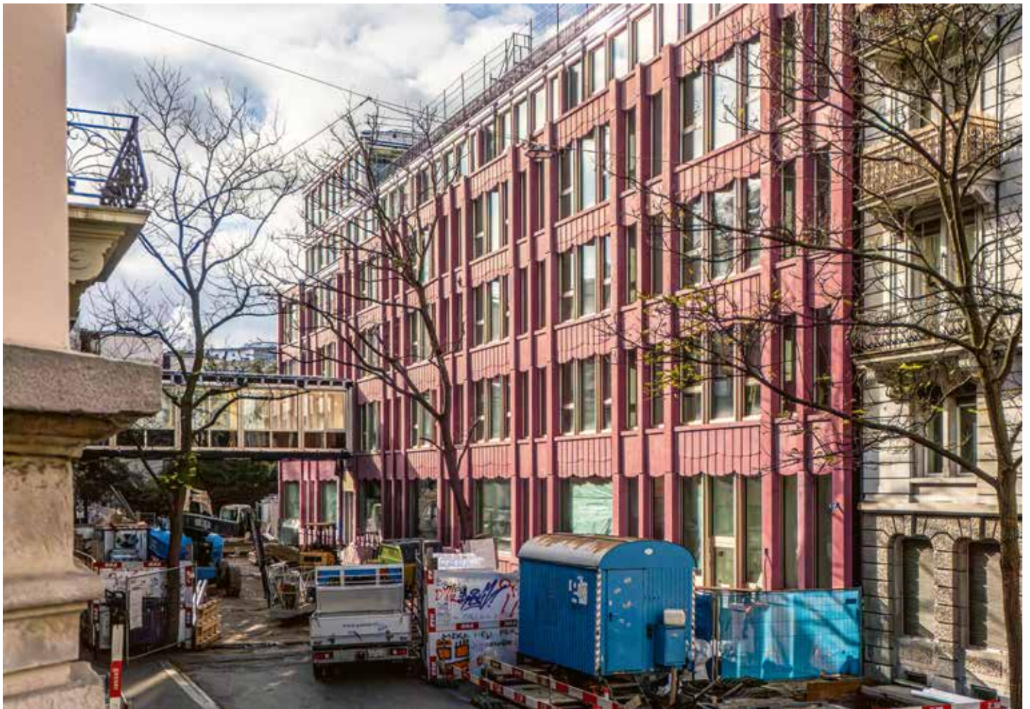
1 Die vielgliedrige Fassade aus rotem Faserzement umspannt neu den Bestandsbau und wird im Winter 2025 montiert.
