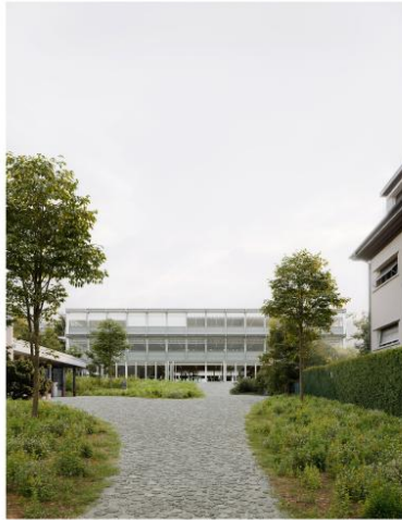
Vue sur le site scolaire et l'entrée de classe avant le début des travaux de construction.
