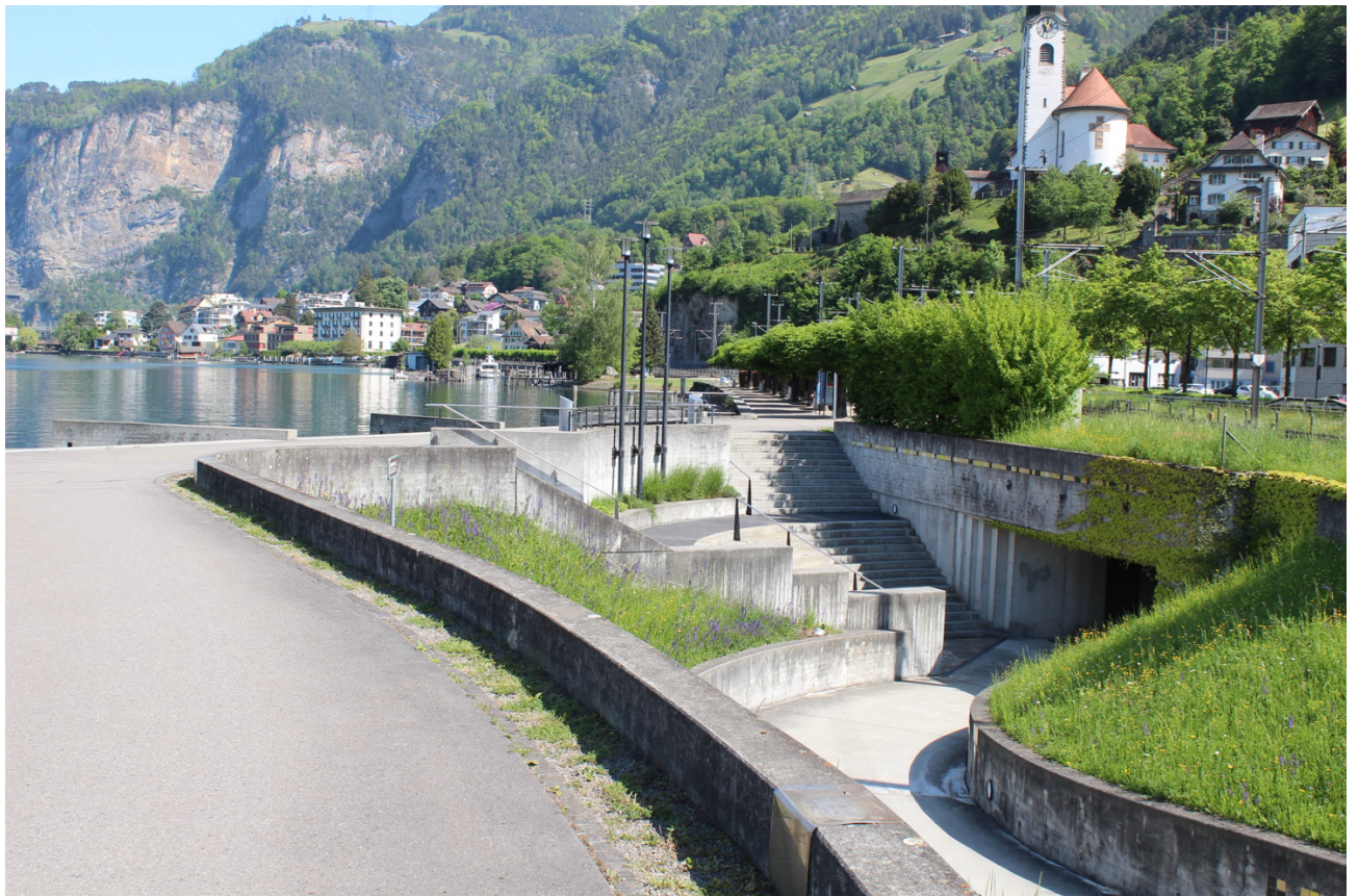
Abb. 17 Seeseitiger Aufgang der nördlichen Unterführung (unten)
