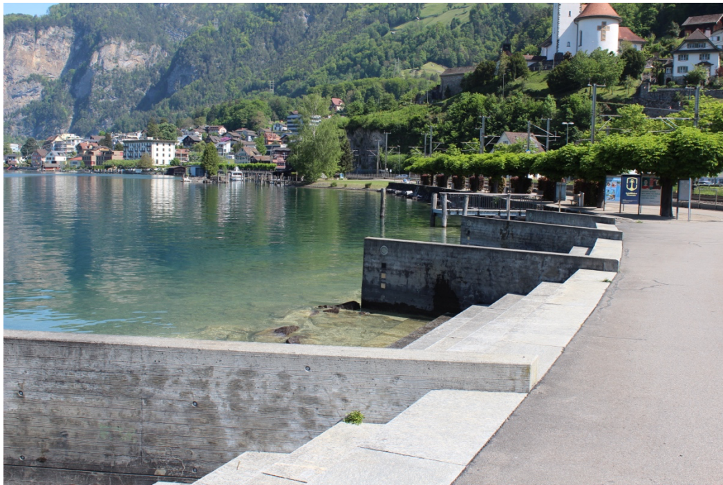
Abb. 16 Bestehende Treppenanlage als Seezugang im Bereich der nördlichen Unterführung (links)
