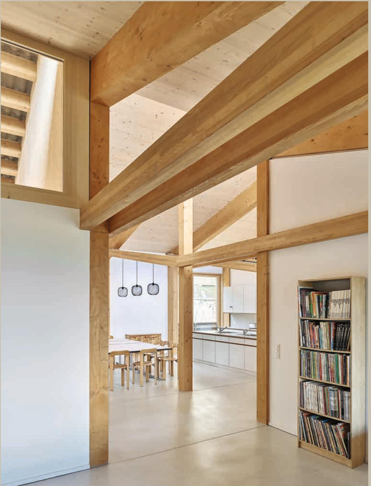
1 Die Stützen im oberen Geschoss hängen an den Dachbindern und tragen den Boden des Internats.
